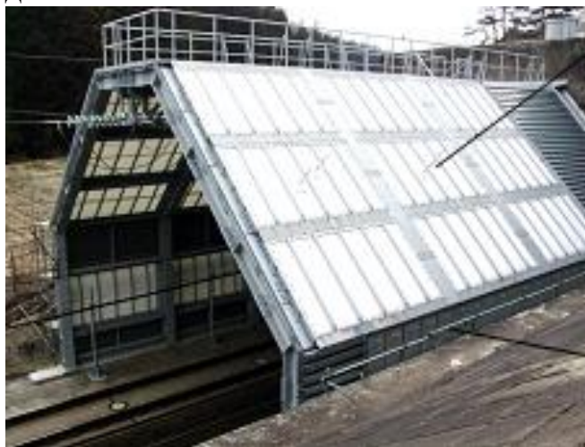
Рисунок 3.9 - Выносная порталная конструкция из композитных материалов
